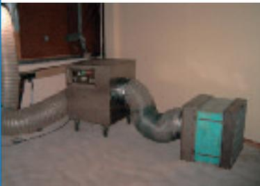
*Bild 9: Technische Entlüftung bei starkem Schimmelpilzbefall*
