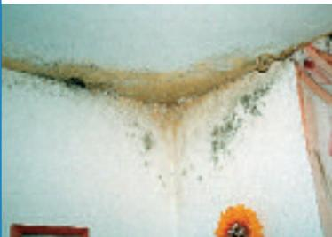
*Bild 4: Schimmelpilzbefall undichtes Flachdach*
