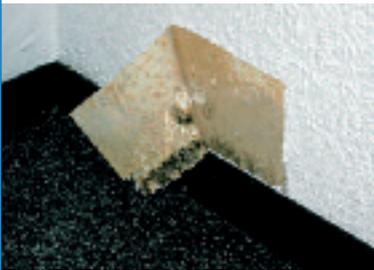
*Bild 3: Schimmelpilzbefall unter der Tapete*
