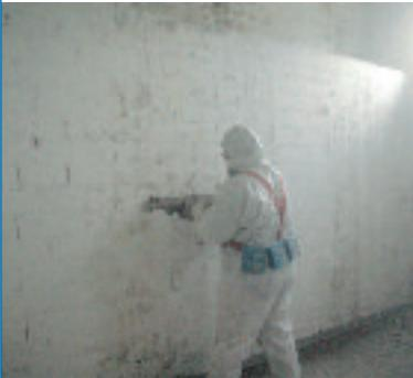
*Bild 5: Beispiel für starke Sporenexposition (Gefährdungsklasse 3) beim Abschlagen von Putz ohne Absaugung*
